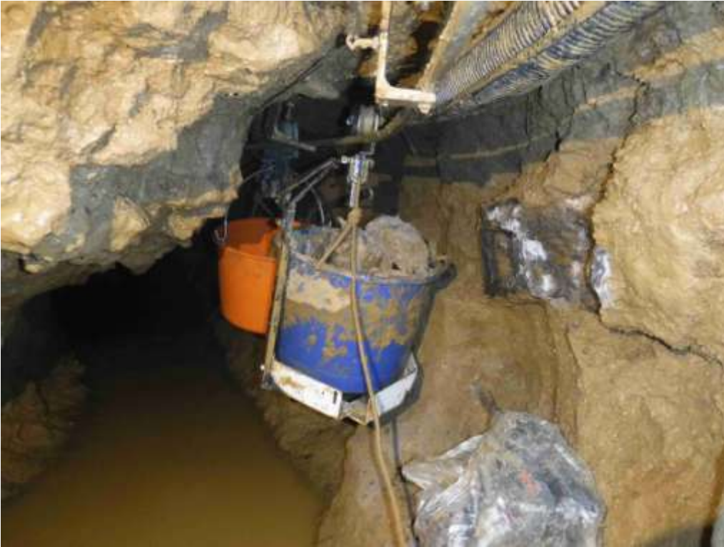
Bild 1 - Gangerweiterung nachher, der Fels ist schon im Eimer
